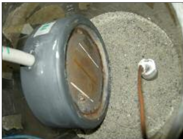
FIG. 6 Sonda e anodo di Mg.
