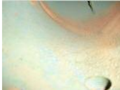
FIG. 13 Aspetto della pittura sollevata in quasi tutta la sua estensione da molteplici bolle.
