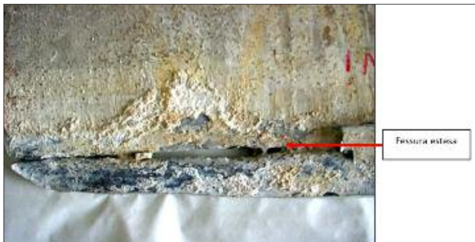
FIG. 21 Aspetto di un giunto saldato in un tratto completamente corrosivo.
